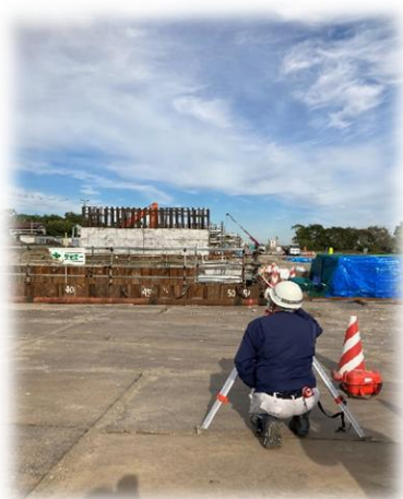
施工状況の確認
