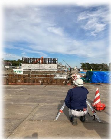
施工状況の確認
