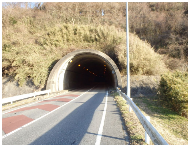
写真 1 板倉トンネル全景写真（起点側）
