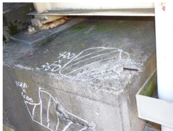
写真 4 橋台のうき・剥離・鉄筋露出(Ⅲ判定)
