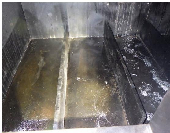
写真 3 橋脚梁部(内部)の漏水・滯水(Ⅲ判定)
