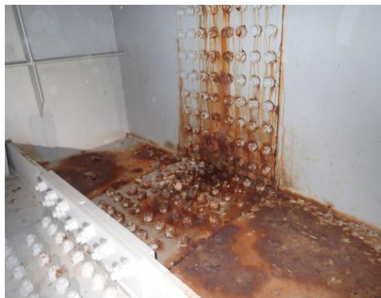
写真 1 主桁(箱桁内部)の腐食(Ⅲ判定)
