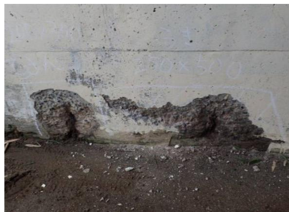
写真 2 側壁の剥離・鉄筋露出(Ⅲ判定)
