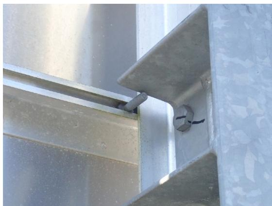
写真 4 標識板取付部ナット脱落(Ⅱ判定)
