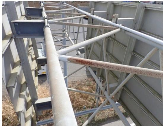
写真 2 横梁トラス部の腐食(Ⅱ判定)
