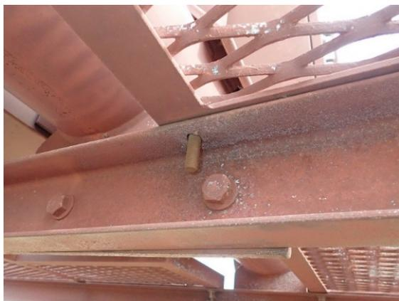
写真 3 管理用の足場・作業台 ナット脱落(Ⅱ判定)
