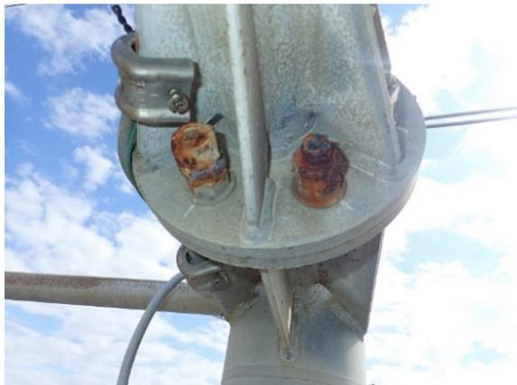
写真 1 横梁取付部のボルト腐食(Ⅱ判定)
